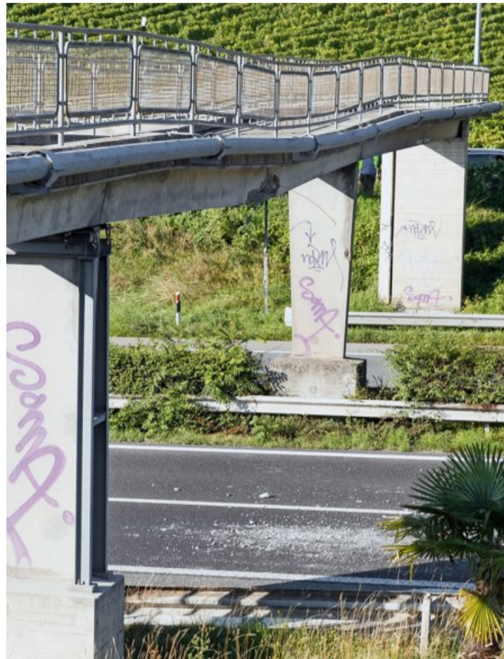
Éraflée par en dessous par un camion, la passerelle enjambant l'A9 formait une vague menaçante. KEYSTONE
