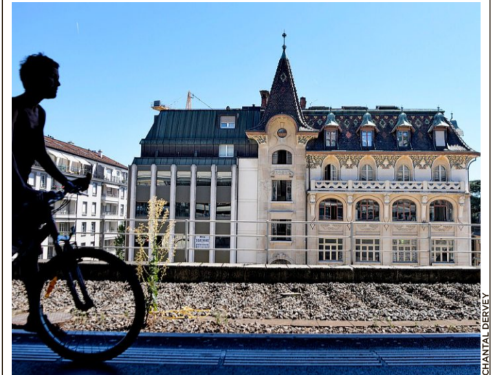
La démolition de l'immeuble du passage des Saugettes pour les travaux de la gare redonne une perspective inédite sur la perle de 1906 de la rue du Simplon 25.
