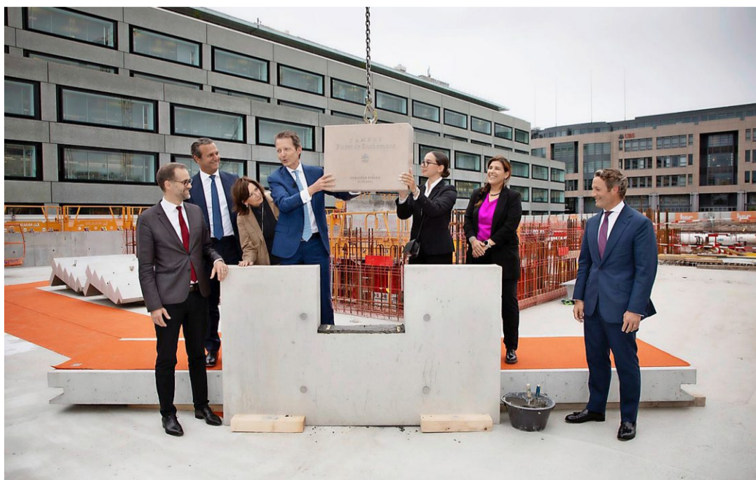
La première pierre symbolique a été transportée par une des grues du chantier. GEORGES CABRERA
