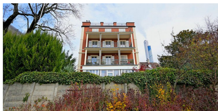
La villa Mont Charmant doit laisser sa place à un immeuble moderne de 42 logements. CHRISTIAN BRUN
