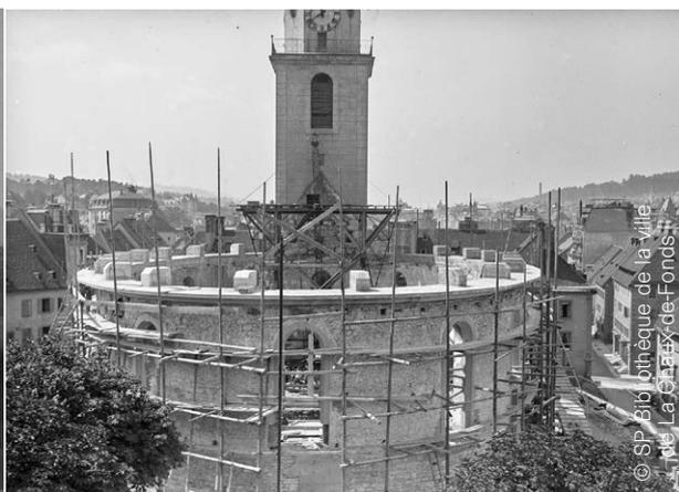
Le chantier avant la construction de la charpente métallique qui soutiendra la toiture.
