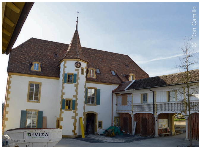
Le château de Montmirail en pleine rénovation.
